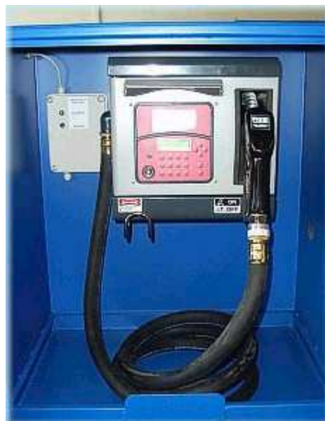
Výdejní čerpadlo MC 50 s přístupovým kódem pro 50 účastníků (50 l/min., 230 V) výdejní pistole se stop ventilem 51.935,- Kč bez DPH
